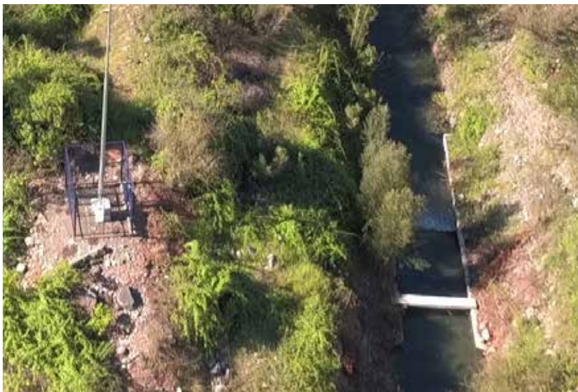
FIGURA 24. Sistema de telemetría instalado en una estación de aforo de un río.
