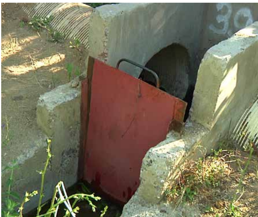
FIGURA 14. Compuerta de ingreso a predio
