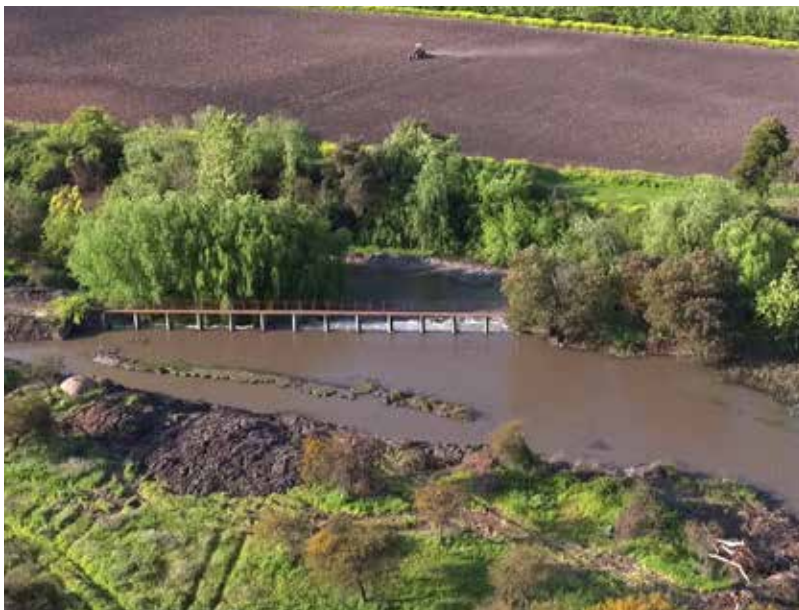
FIGURA 4. Bocatoma permanente en lecho del río embancado, que altera ingreso del agua.
