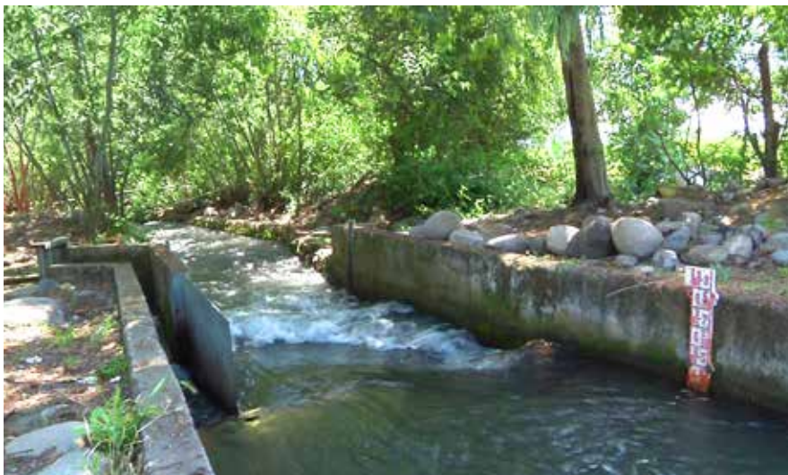
FIGURA 2. Sección de control de obra permanente que mide el agua mediante regla graduada y distribuye por marcos partidores.
