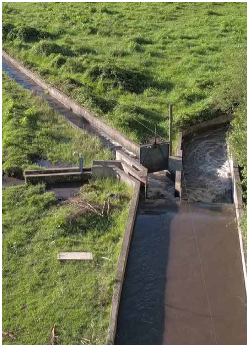
FIGURA 12. Obra de distribución del agua (marco partidor y compuertas).
