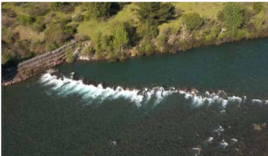
FIGURA 5. Bocatoma estacional conformada por una barrera frontal al río, que permite alcanzar la altura y velocidad adecuadas para el ingreso del agua al canal (a la izquierda de la fotografía).
