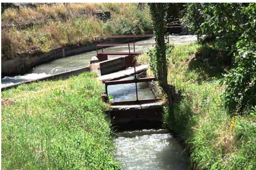
FIGURA 3. Sección de control de obra permanente que mide el agua mediante regla graduada y distribuye a través de compuerta.
